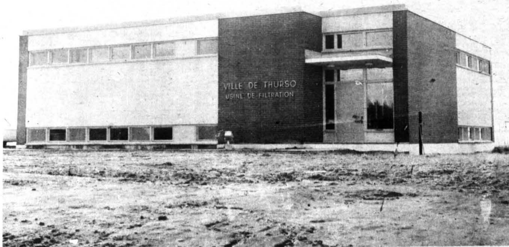
Voici une vue générale de la Centrale de traitement des eaux à Thurso. Le revêtement extérieur est en brique brune et en agrégat de granit blanc. Dans quelque temps, la population de Thurso sera invitée à visiter ce projet réalisé à la satisfaction de tous.
