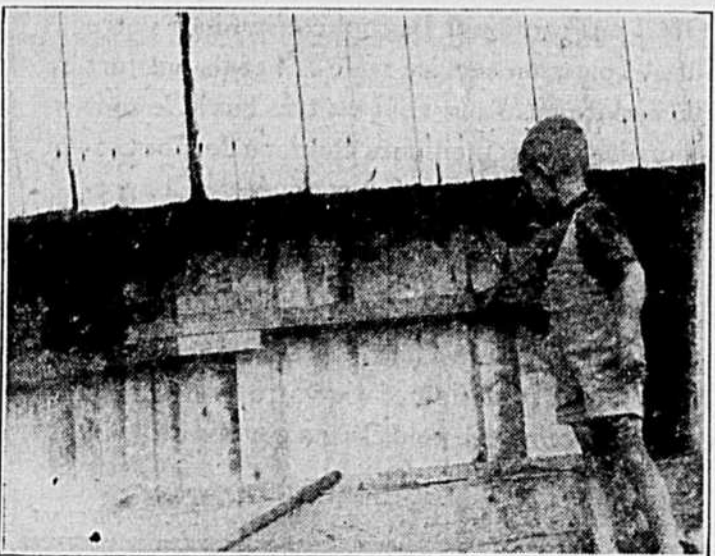
Base de l'un des deux silos de 8' 3" x 24' que dissimule la grange de M. Gérard Audet, le premier cultivateur à ensiler du foin dans la paroisse de St-Anselme (Dorchester).
