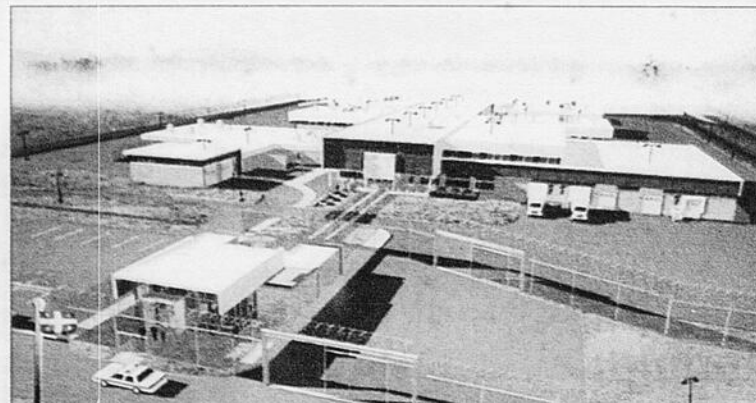
Québec a annoncé cette semaine le début de la construction du futur centre de détention de Roberval.
