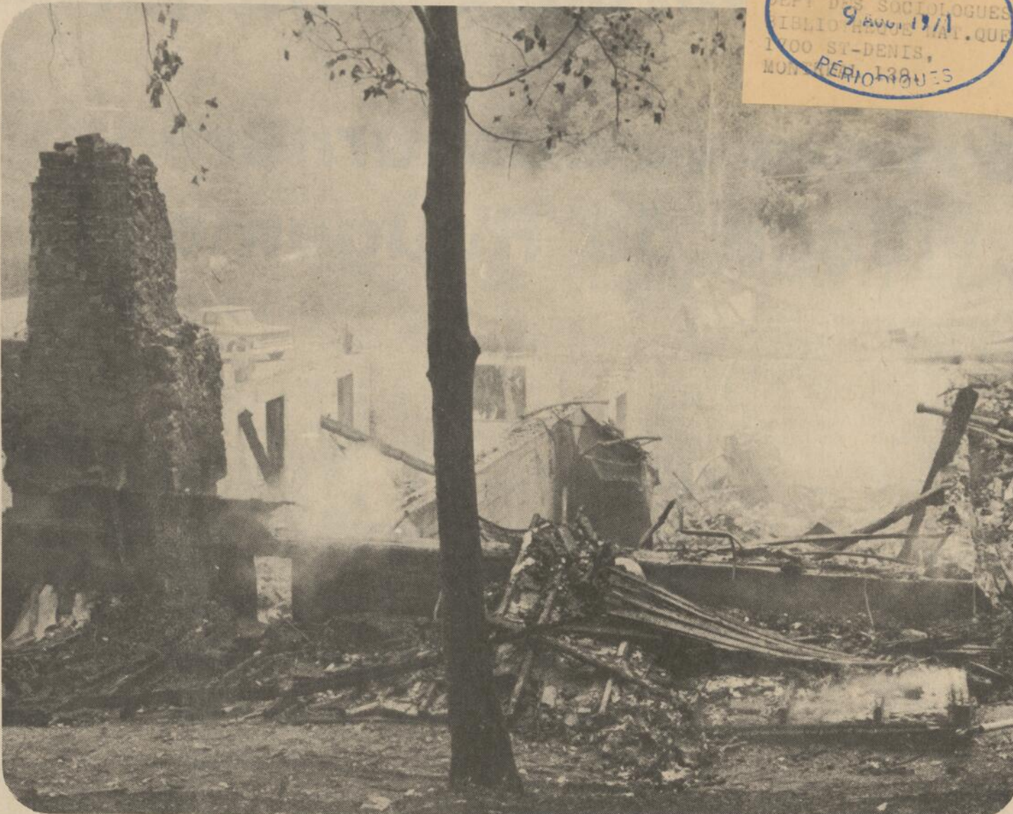
L'Auberge des Erables, au Lac Bowker, a été totalement rasée par les flammes l'autre nuit. La violence de l'incendie a réduit tout l'édifice en cendres qui, quelques heures plus tard fumaient encore. On ignore encore les causes du sinistre et une enquête a été instituée pour permettre de les déterminer. Malgré l'heure tardive du sinistre, il n'y a pas eu de victime.
