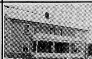
275 ouest, rue Notre-Dame. Maison 4 logements.
