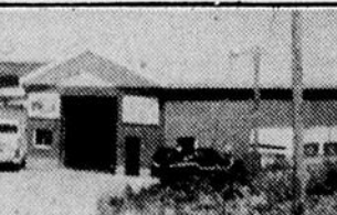
Rimouski, rue Ste-Odile, commerce d'excavation et de terrassement.
