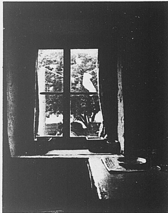
Cette fenêtre encastrée dans des murs très épais ferait aujourd'hui l'effet d'une meurtrière...
