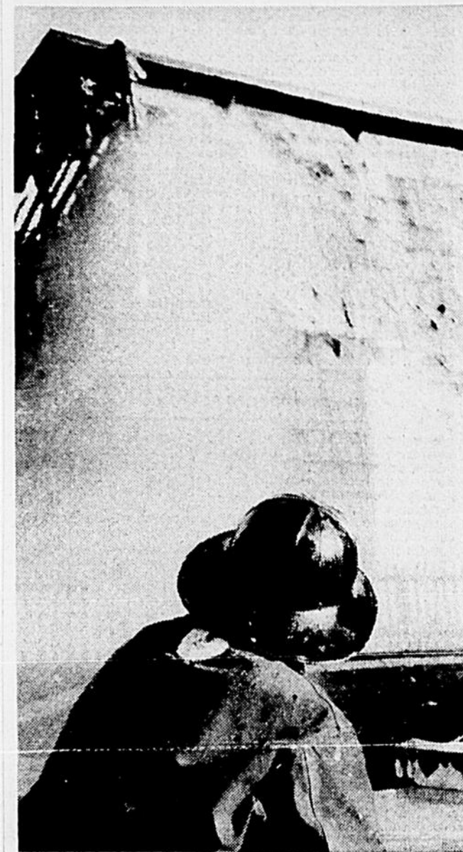
Un violent incendie a complètement ravagé l'entrepôt de la firme H. Létourneau Ltée, à La Providence, causant des pertes matérielles très lourdes. Les pompiers volontaires de l'endroit ont travaillé ferme pendant deux heures avant de maîtriser les flammes qui menaçaient de se communiquer aux bâtisses des alentours.
