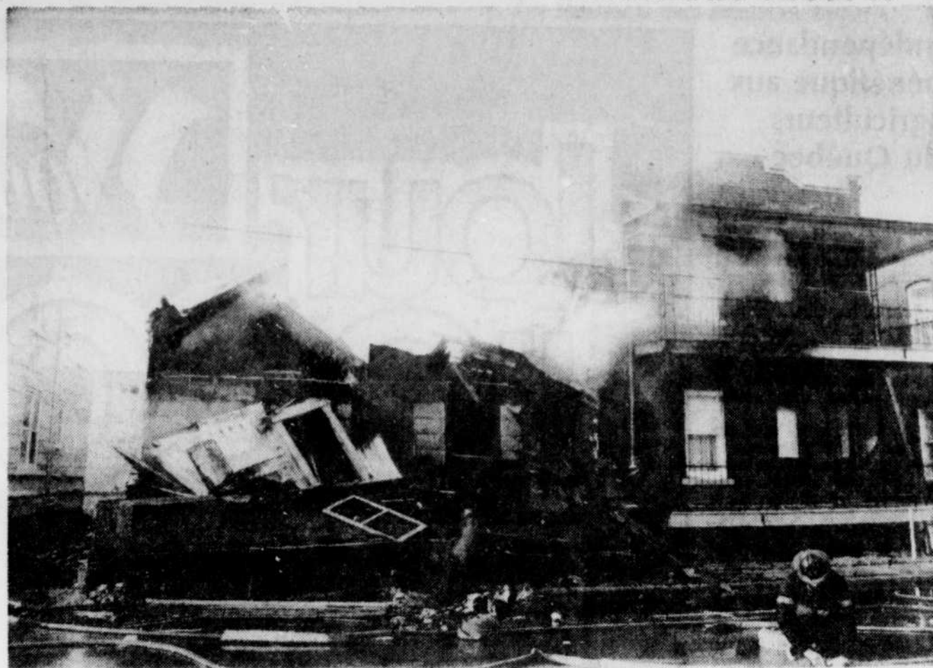
Autant la devanture que l'arrière, le bâtiment du 361 Brock a été complètement détruit par les flammes. (Photo La Tribune, par Gerald Prince)
