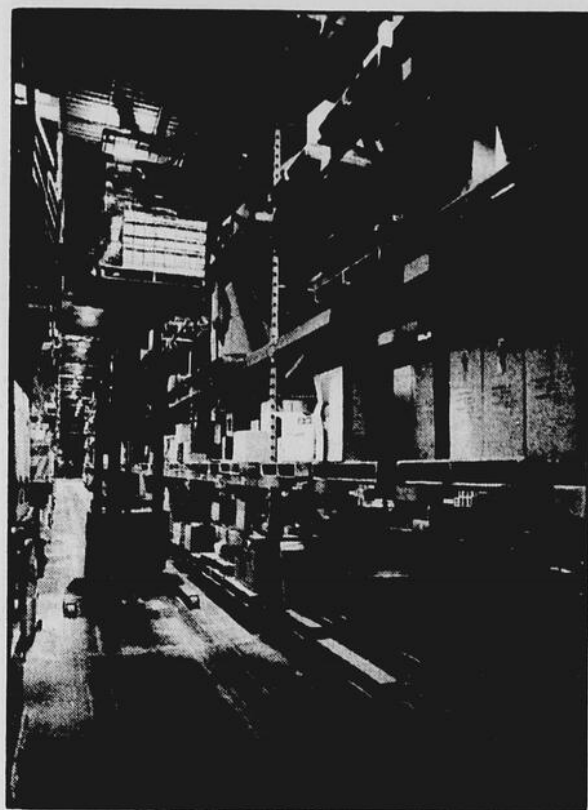
Vue intérieure de l'entrepôt de Boucherville.
