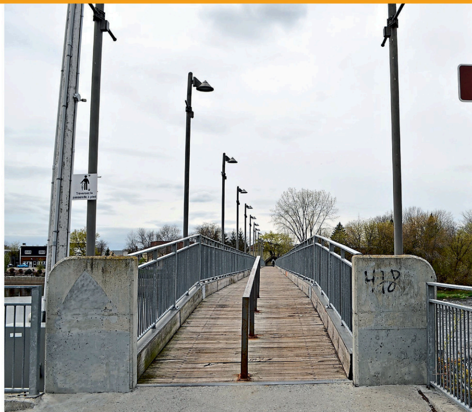
La mise à niveau du barrage et de la passerelle Éva-Dulude pourrait coûter jusqu'à 12 M$. (Photo: L'Avenir Des Rivières - Claude Hébert)
