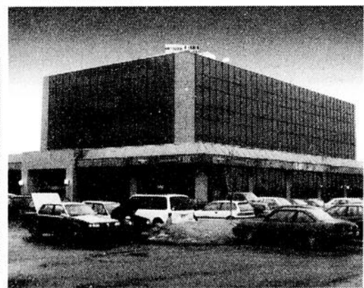
6300, RUE AUTEUIL, BROSSARD
