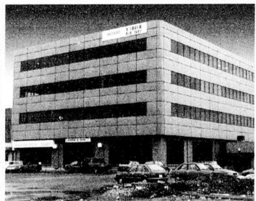
6400, RUE AUTEUIL, BROSSARD
