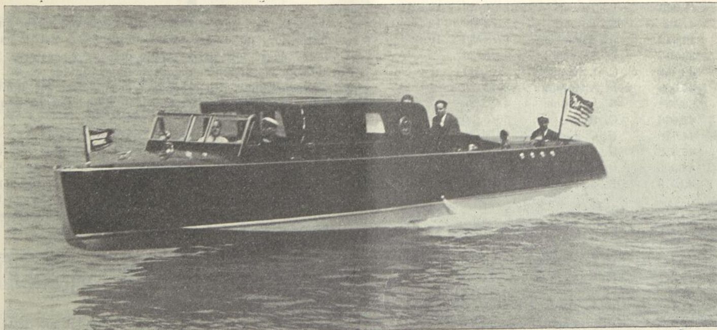
La tendance moderne dans les vaisseaux de grands luxe. Un superbe Hackercraft de 38 pieds acheté récemment par le Roi de Siam. Le pouvoir de ce bateau est d'un 12 cylindres Packard de 860 c.v., poussant le bateau jusqu'à 63 milles à l'heure dans les premières épreuves. La coque se distingue par le dessin hydroplaine simple.
