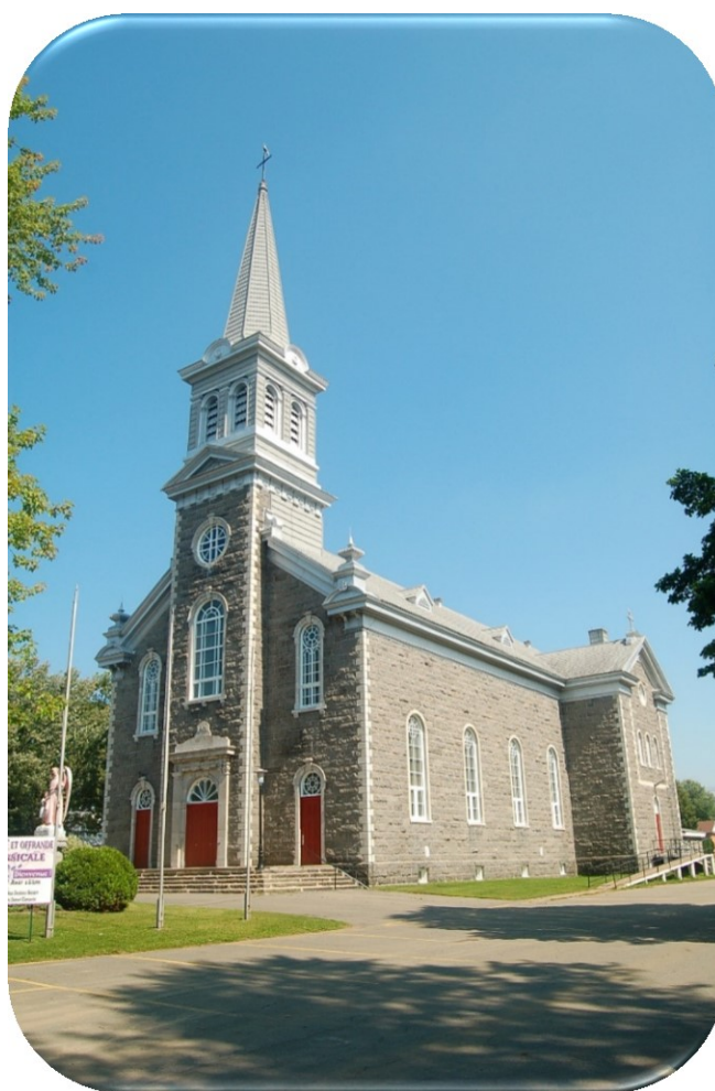
Église Saint-Boniface, Saint-Boniface-de-Shawinigan
