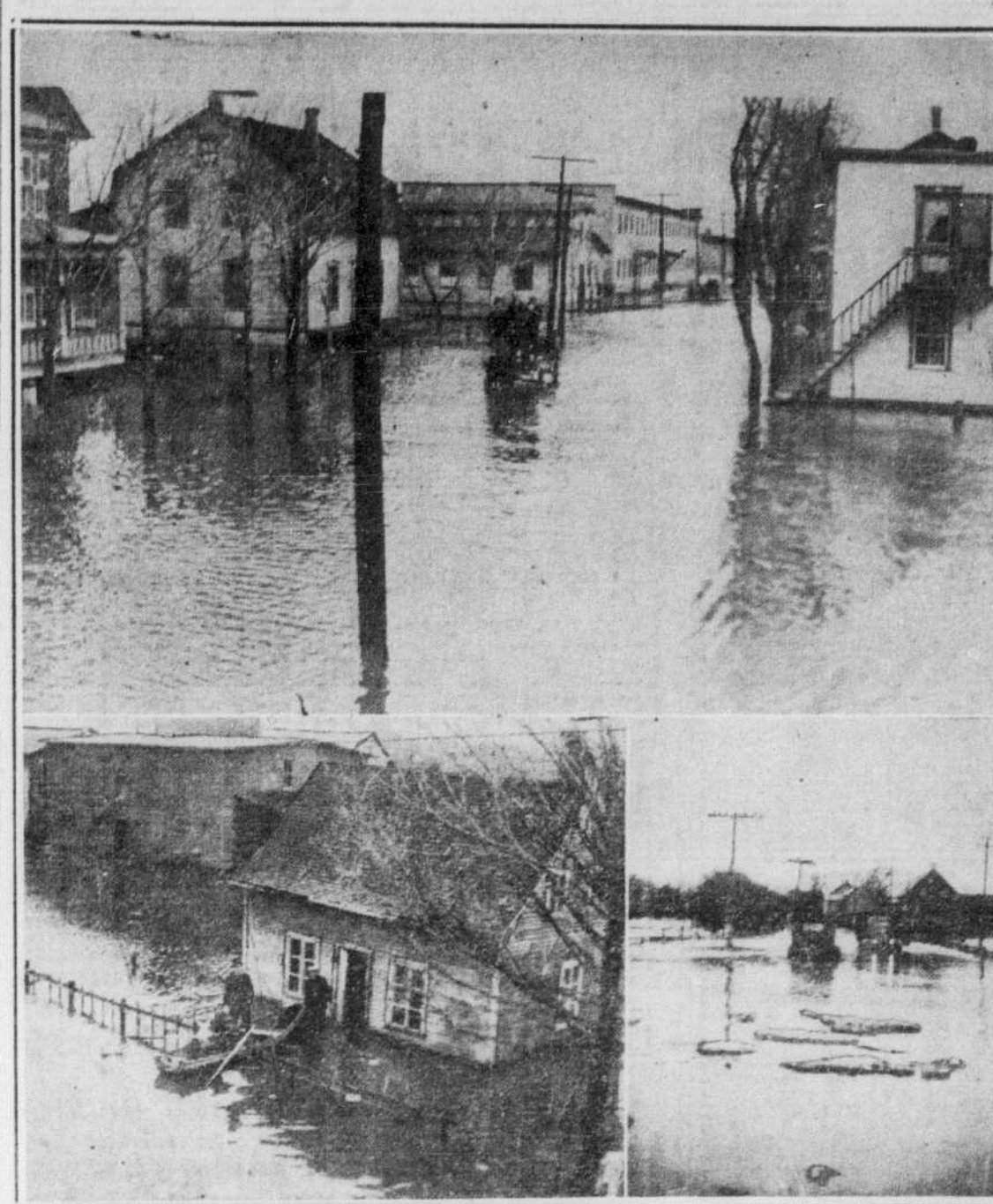
À la suite des fortes pluies que nous avons eues plusieurs rivières ont débordé dans la province et ont causé des dommages considérables. Dans les vignettes ci-haut, on voit en bas, à gauche, des citoyens de la rue Debiarée à Victoriaville arrivant à leur demeure en chaloupe. À droite, les deux derniers autos qui ont pu circuler, hier matin, sur la route Caughnawaga-Malone à Sainte-Martine. Peu après, cette photo eut été prise le niveau de l'eau monta rapidement et la circulation des autos y fut complètement interrompue. En haut une vue générale de la rue Debiarée à Victoriaville où c'est la première fois, de mémoire d'homme, que se produit une inondation.
