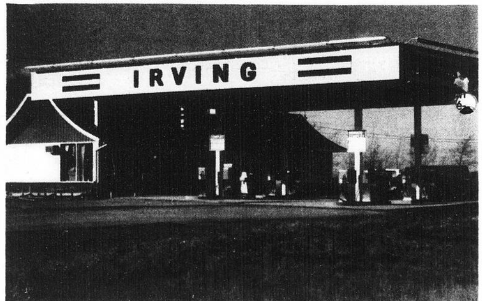
Les travaux de rénovation du Restaurant Irving Etape 185 Enr. à Rivière-Verte étant terminés, les propriétaires Michelyne & Réginald Ferland ont servi des rafraichissements à leurs clients durant la fin de semaine du 10 au 11 novembre 1979. Une marquise a été installée pour une grande satisfaction des automobilistes. Le restaurant et la salle à manger ont été agrandis.
