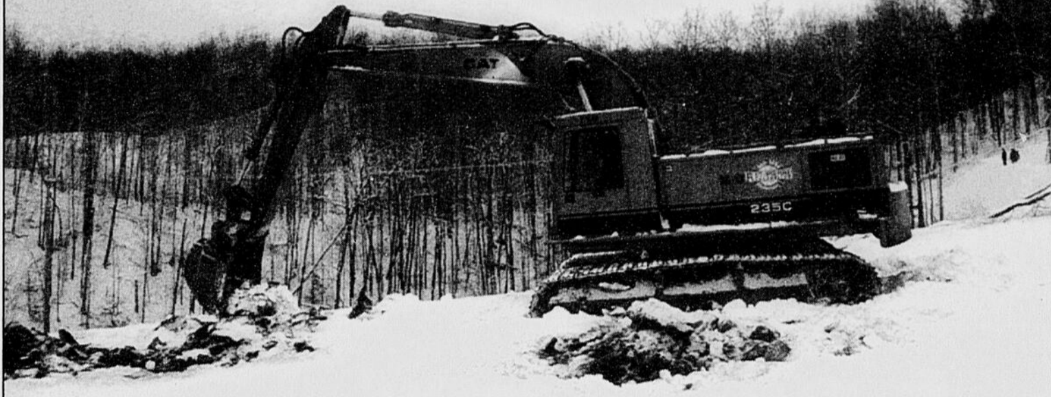
Des équipes ont entrepris dès hier de creuser des tranchées de 3 à 15 mètres de profondeur dans la partie ouest du lieu d'enfouissement sanitaire, afin de favoriser l'évacuation des biogaz qui gâchent la vie des résidents du développement Dubreuil. À gauche, dans l'ordre habituel, Dominique Boivin, André Jetté et Johanne Poulin.
