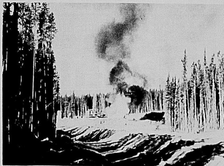
Le derrick est démantelé. Les maîtres-sondeurs vont partir, laissant derrière eux quelques tuyaux sous terre et autour du puits, des souvenirs. Demain, ce sera l'exploitation!
