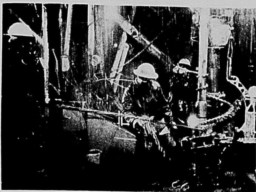
Un trépan neuf et tout est à recommencer. Mais à l'envers cette fois. Les 8,000 pieds de la tige flexible comme un fil doivent redescendre dans les profondeurs. Il n'y a qu'une façon pratique de visser rapidement les tiges: la chaîne. Dangereuse, rapide comme un fouet. Elle peut vous arracher un doigt...
