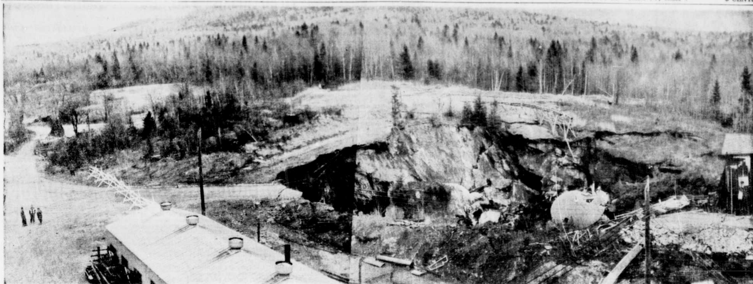
LA TERRE S'EFFONDRE AU-DESSUS DES Puits DE MINE DE CUIVRE A FONTAINEBLEAU. — Cette photographie donne une excellente idée des dégâts causés hier matin à la "Weedon Mining Corporation" de Fontainebleau où le
