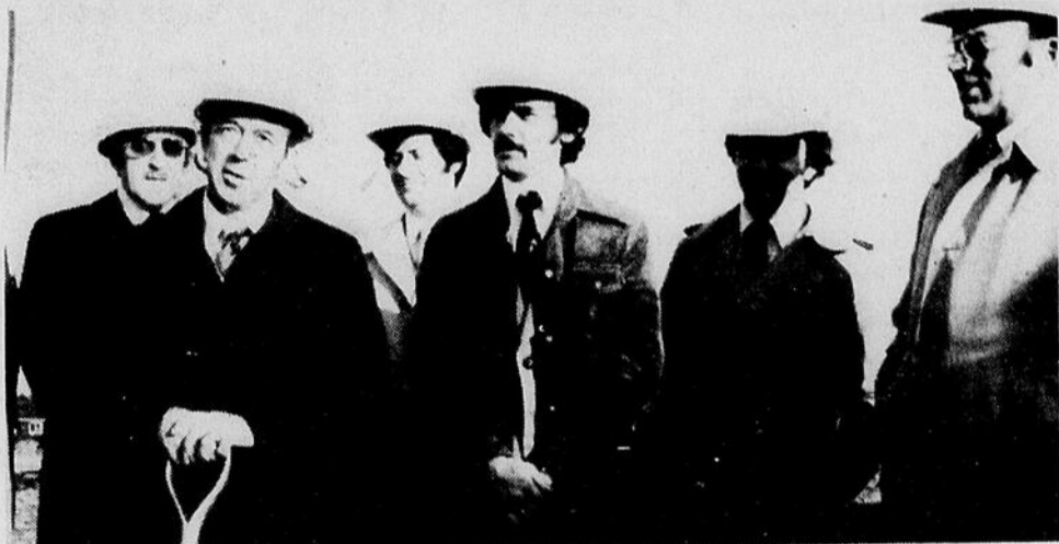
Photo prise lors de la levée de la première pelletée de terre. On reconnaît le président de Télé-Capitale Inc. [appuyé sur la pelle] M. Jean Pouliot, le député provincial de Rimouski M. Alain Marcoux, M. Charles Ross, architecte du projet et l'entrepreneur M. J.-Roger Lévesque. Entre MM Pouliot et Marcoux, M. Gilles Grégoire, directeur général de CFER-TV, canal 11, Rimouski.
