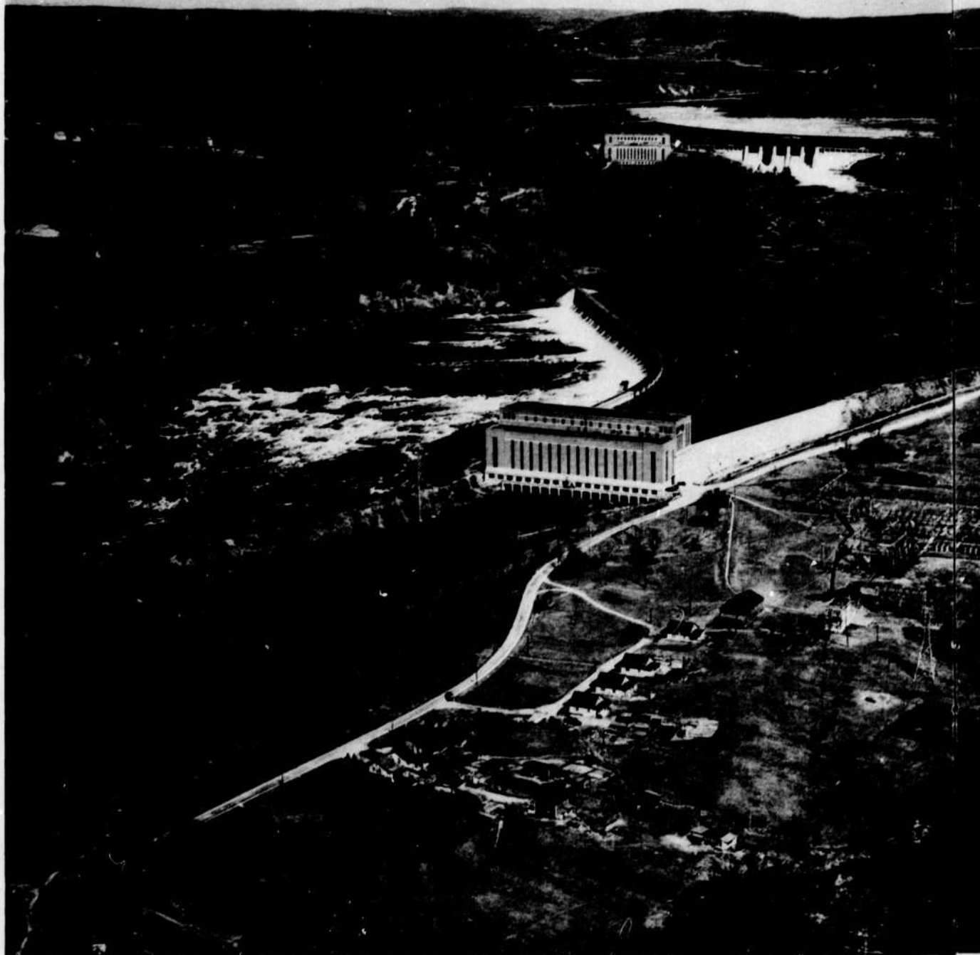
Usines de Farmers et Chelsea sur la rivière Gatineau, à 4½ et 6 milles respectivement au nord de sa confluence avec la rivière Ottawa. Ces usines ont ensemble une capacité de 290,000 hp.
