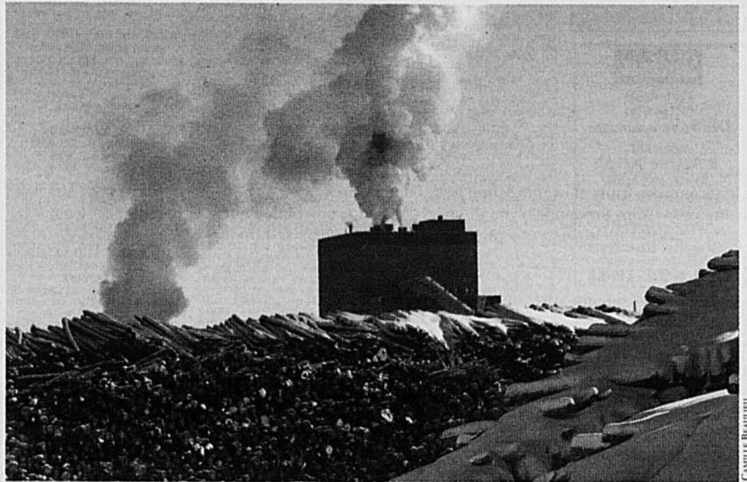
L'usine de Boralex à Senneterre
