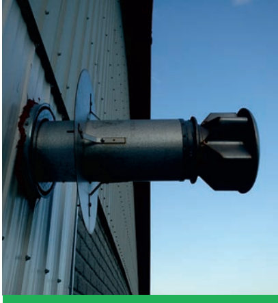
Cheminée d'évacuation des gaz à l'extérieur du bâtiment.
