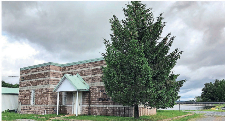
L'usine d'épuration des eaux usées date de 1994 et n'a jamais été agrandie depuis sa construction. (Photo: gracieuseté)
