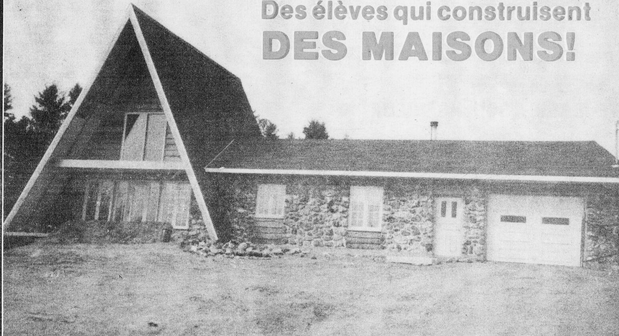
Cette magnifique maison est l'oeuvre des élèves du cours «Travailleurs de la construction» du Secondaire VI de la Polyvalente Benoit-Vachon.
