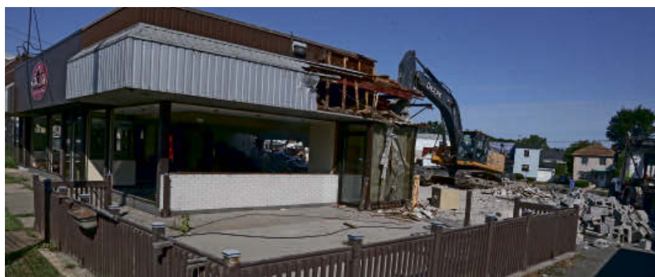
Les équipes de M. Durand ont procédé à la démolition de l'édifice la semaine dernière. Photo Pascal Cournoyer | Les 2 Rives ©
