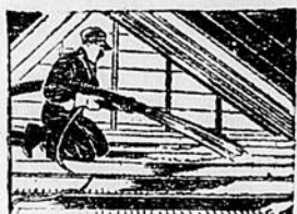
L'isolation étant installée par des experts Gilpin.
