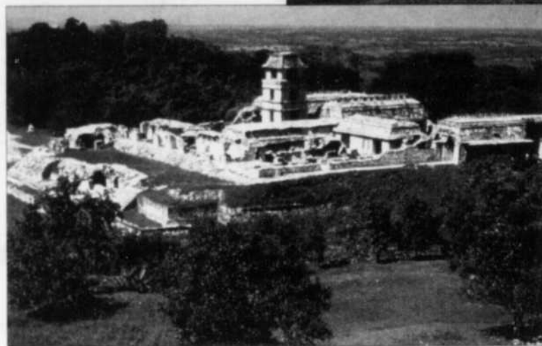
Le site maya de Palenque a été construit sur une succession de terrasses aménagées artificiellement.
