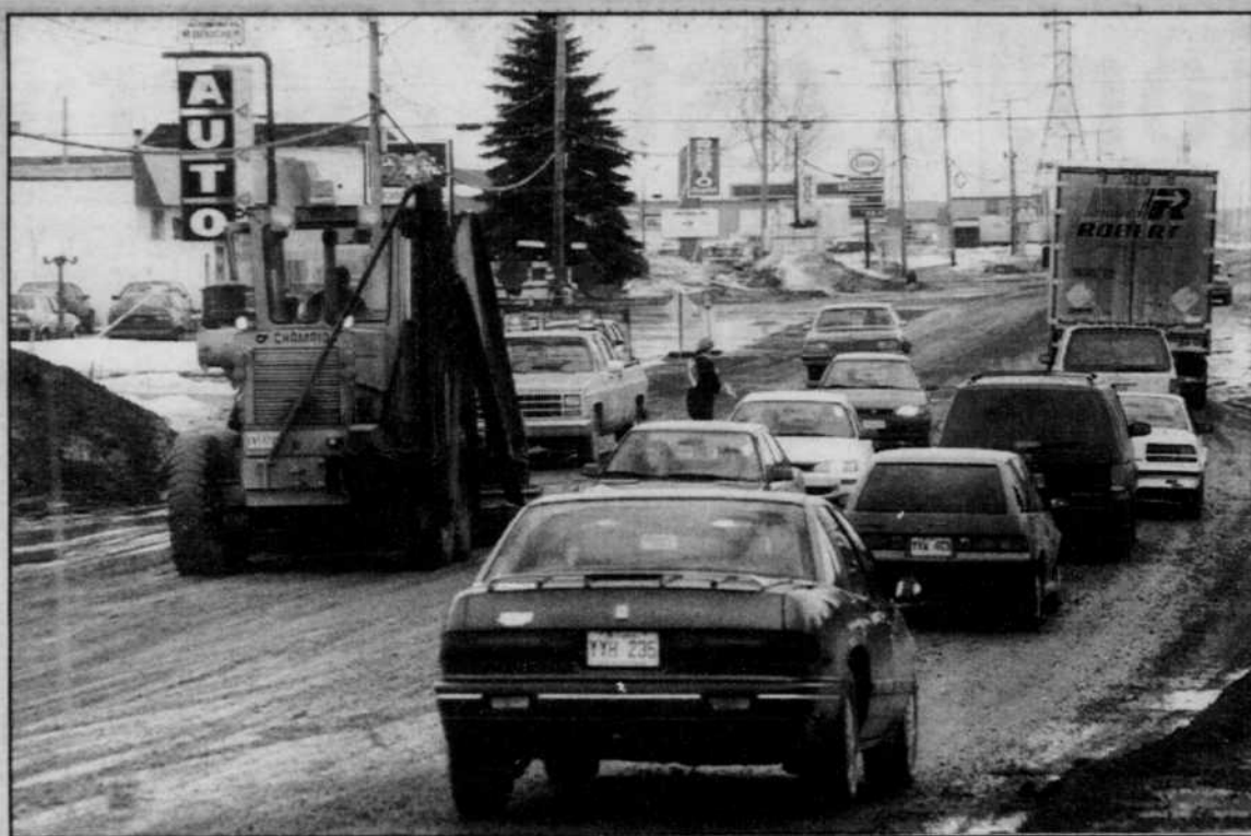
Le temps doux a transformé l'abord du pont de Saint-Césaire en bourbier, malgré les travaux de drainage et de nivellement effectués par le ministère des Transports sur cette chaussée gravellée. photo Alain Dion
