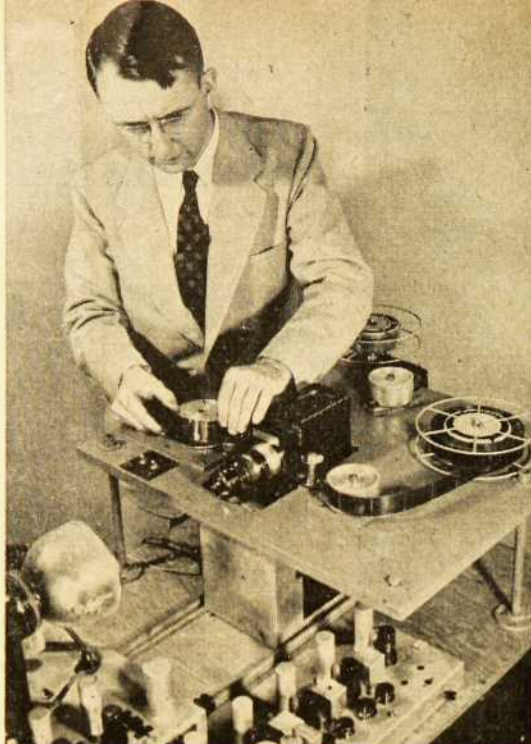
Vue de premier plan d'une partie de l'appareil. L'opérateur place la pellicule des messages à expédier. Au fur et à mesure que le film se déroule, un mince rayon de lumière enregistre les images dans l'appareil. Les impulsions de cette lumière se transforment en impulsions de courants électriques lancées sur les ondes.
