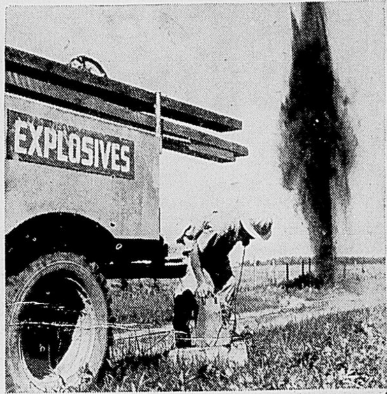
Une équipe de prospection sismique de l'Imperial Oil effectuait des recherches aux environs de St-Grégoire, à sept milles à l'est de Nicolet, l'été dernier. Ses études des formations rocheuses susceptibles de contenir du pétrole font l'objet d'un article du dernier numéro de "La Revue Imperial Oil". L'un des techniciens déclenche une petite explosion qui lance des ondes de vibration jusque dans les profondeurs des couches souterraines.
