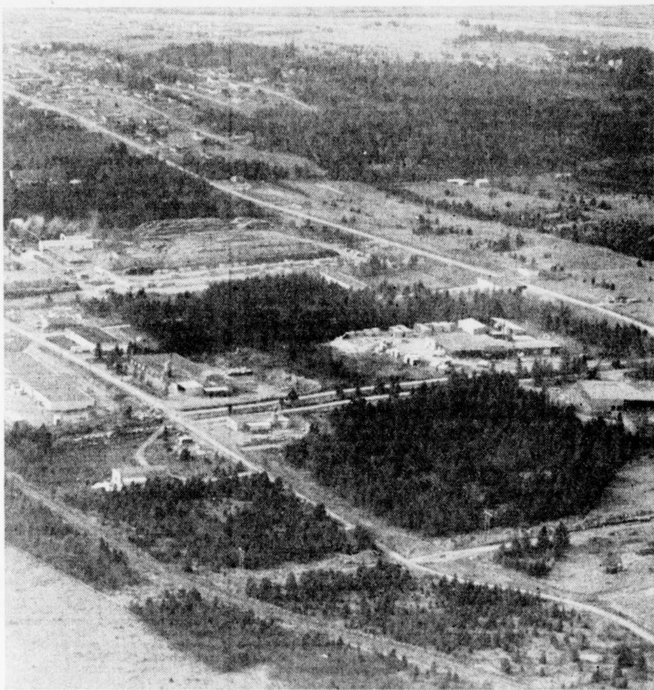
La partie centre du parc industriel de Ville Saint-Georges.
