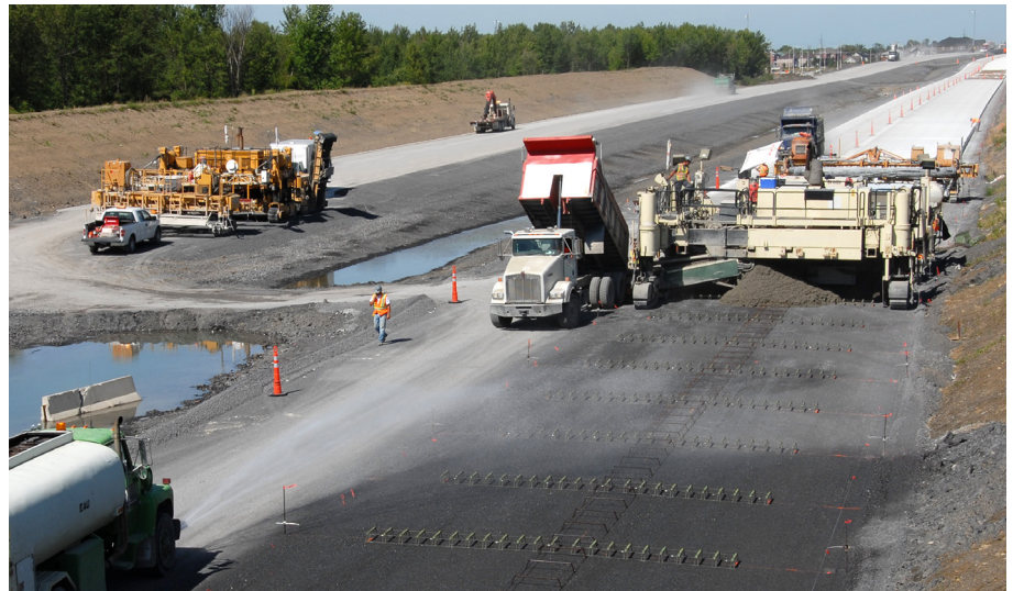
Figure 4 – Chaussée en béton avec tirants et goujons
