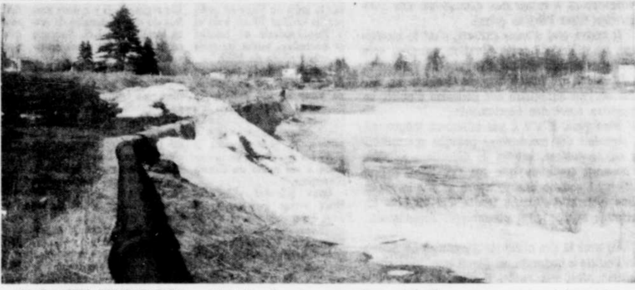
LES DANGERS D'INONDATION semblent écartés cette année, à Drummondville, à moins, bien entendu, que ne survienne une très grosse pluie de plusieurs jours. En effet, la glace a commencé à caler d'elle-même le long des rives de la St-François, et il semble que, dans son état
