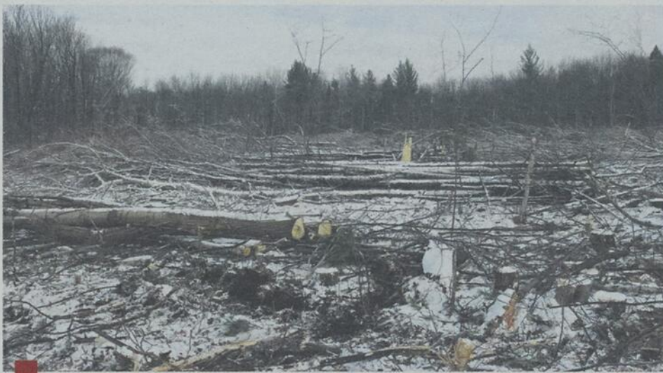
Depuis vendredi, les travaux de déboisement sur le site futur du nouvel aéroport. 100 % de l'espace pour la piste Mascouche sera déboisé. (Photo : Gilles Fontaine)
