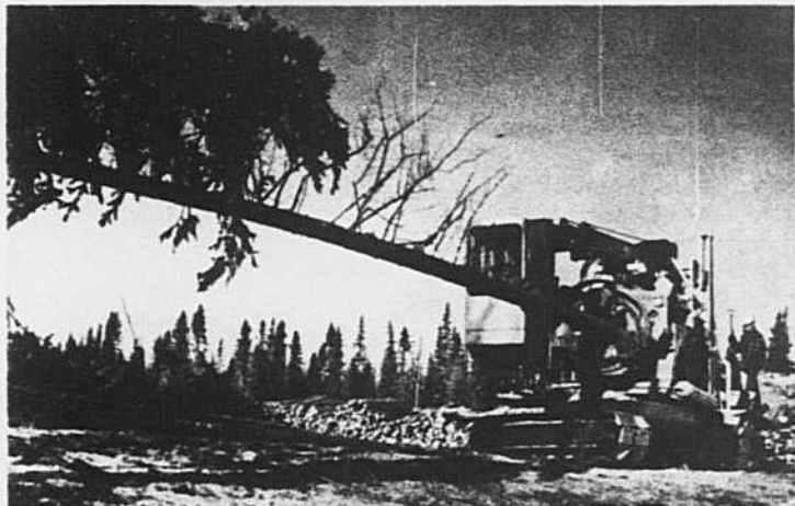
Cette machine, qui sera mise sur le marché bientôt, peut à elle seule, en opérations successives, ébrancher, écorcor, tronçonner et corder le bois sur les lieux même de la coupe.
