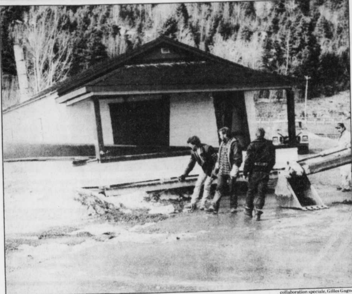
Ce chalet, situé dans la localité de Restigouche-Sud-Est, en aval de Matapédia, a été emporté sur une distance d'un kilomètre par la crue de la rivière Restigouche.
