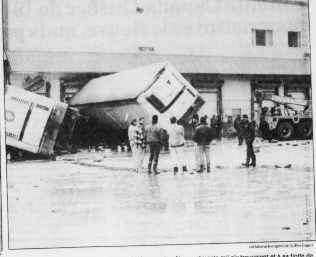
La firme Provigo estime les dommages causés à son entrepôt, aux aliments qui s'y trouvaient et à sa flotte de camions à deux millions$, voire davantage. Des tonnes de denrées diverses jonchent le sol sur plusieurs centaines de mètres autour de l'entrepôt, qui devrait néanmoins être fonctionnel vendredi.
