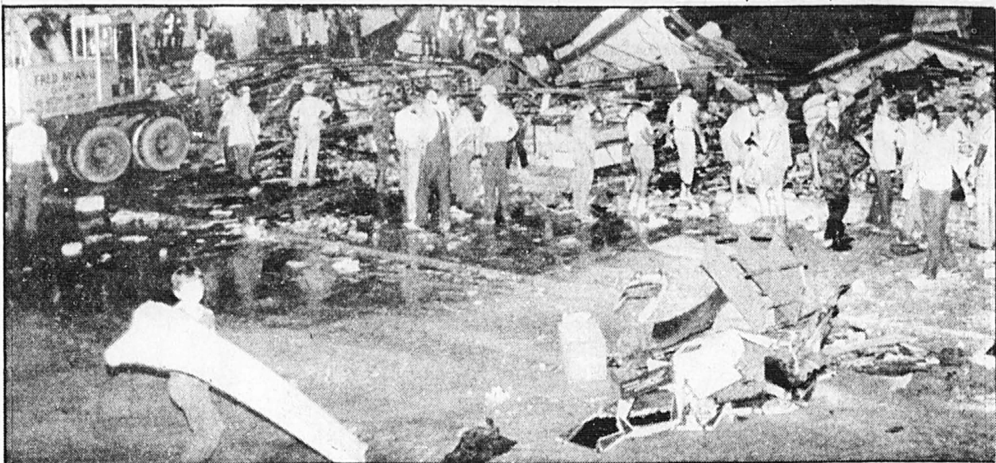
Les secouristes s'activent à rechercher d'éventuels clients enfouis sous les débris d'un centre commercial dont le toit s'est subitement effondré, au Tennessee.
