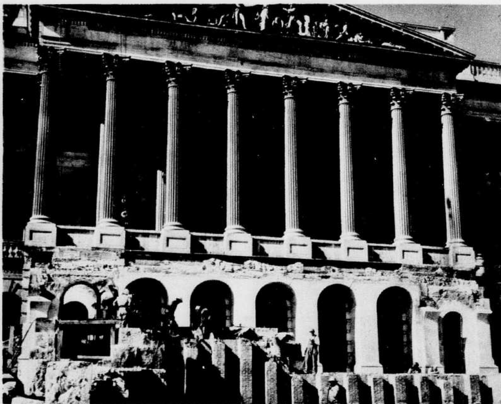
La fondation en briques du nouvel escalier de la partie centrale est presque terminée. D'énormes marches de pierre s'élèveront sur ces fondations.
