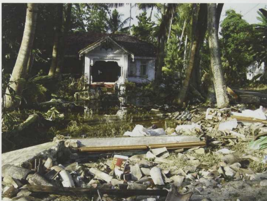
Désolation après le passage du Tsunami
