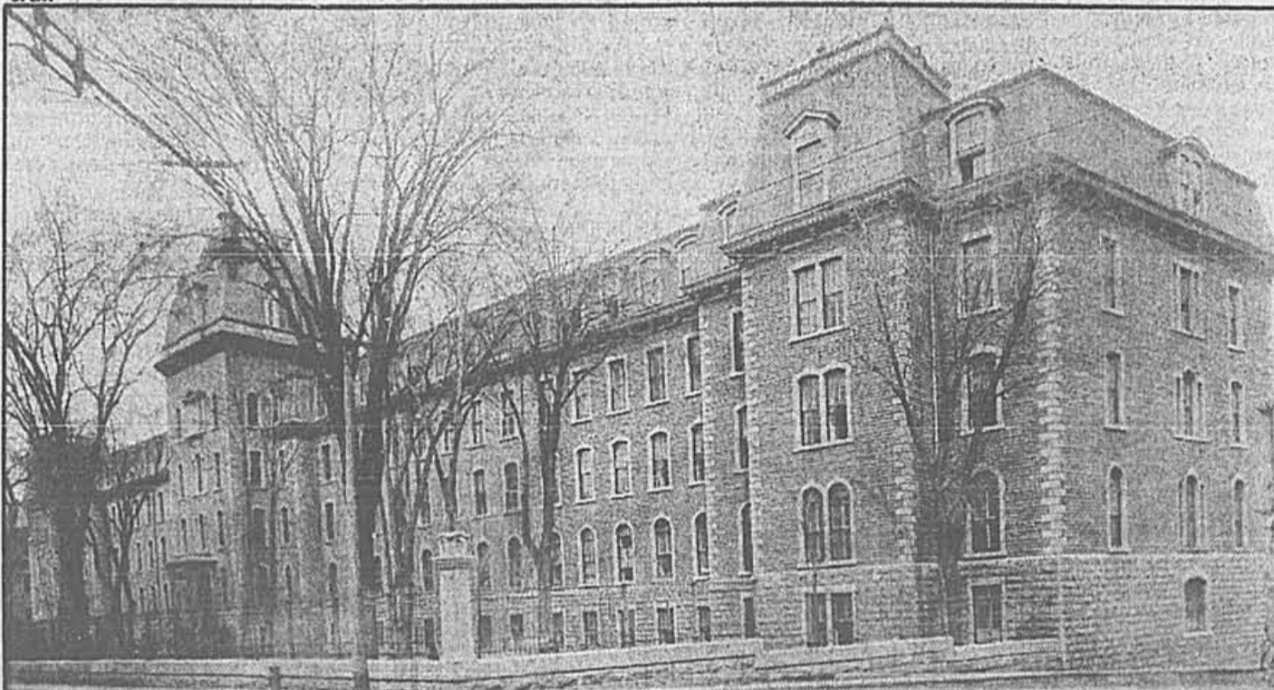
Le collège vers 1910. On notera l'escalier en bois en forme de fer à cheval et la balustrade en fer forgé au sommet de l'avant-corps central.
