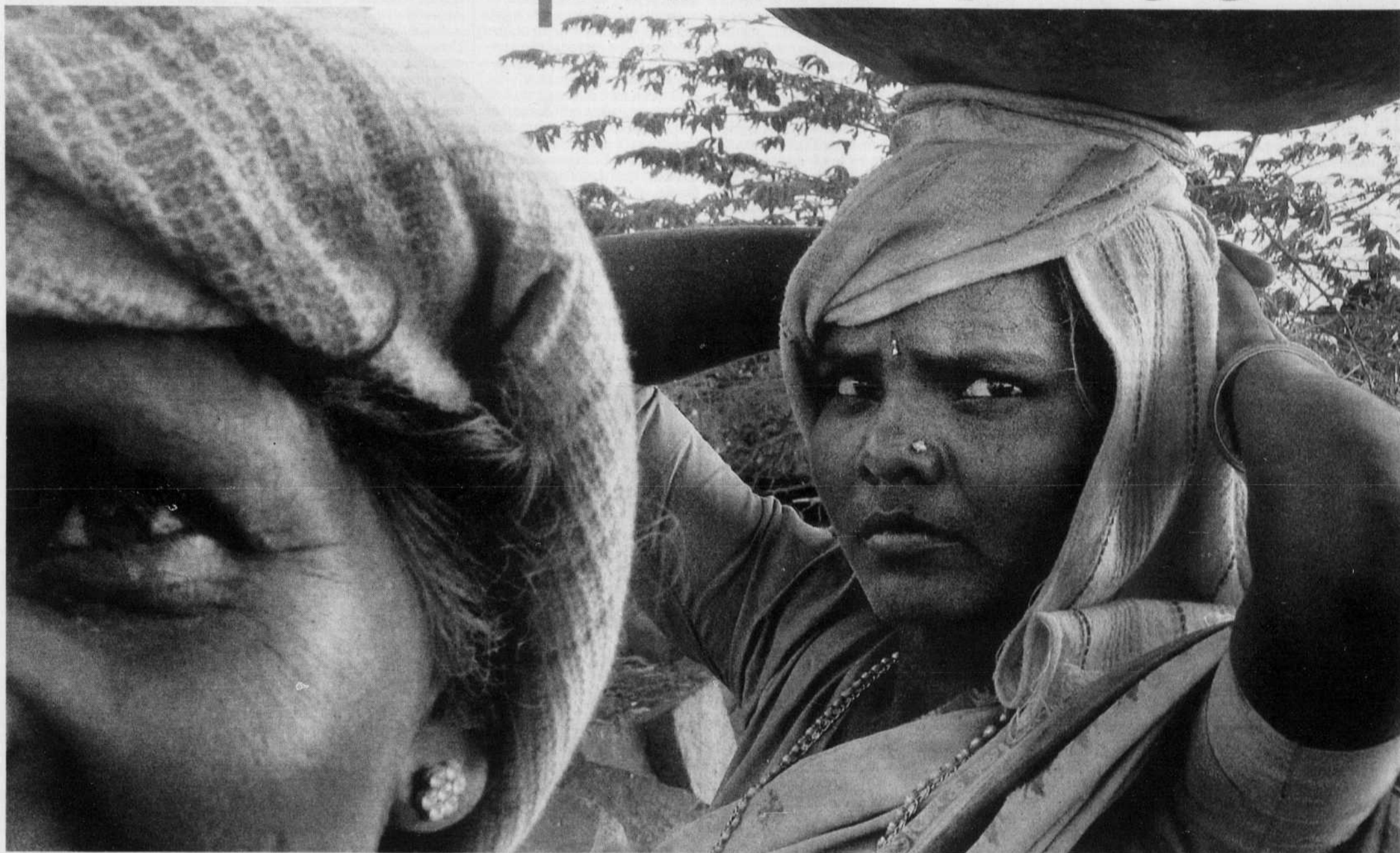
Femmes transportant du ciment servant à la construction d'un trottoir à Bombay.
