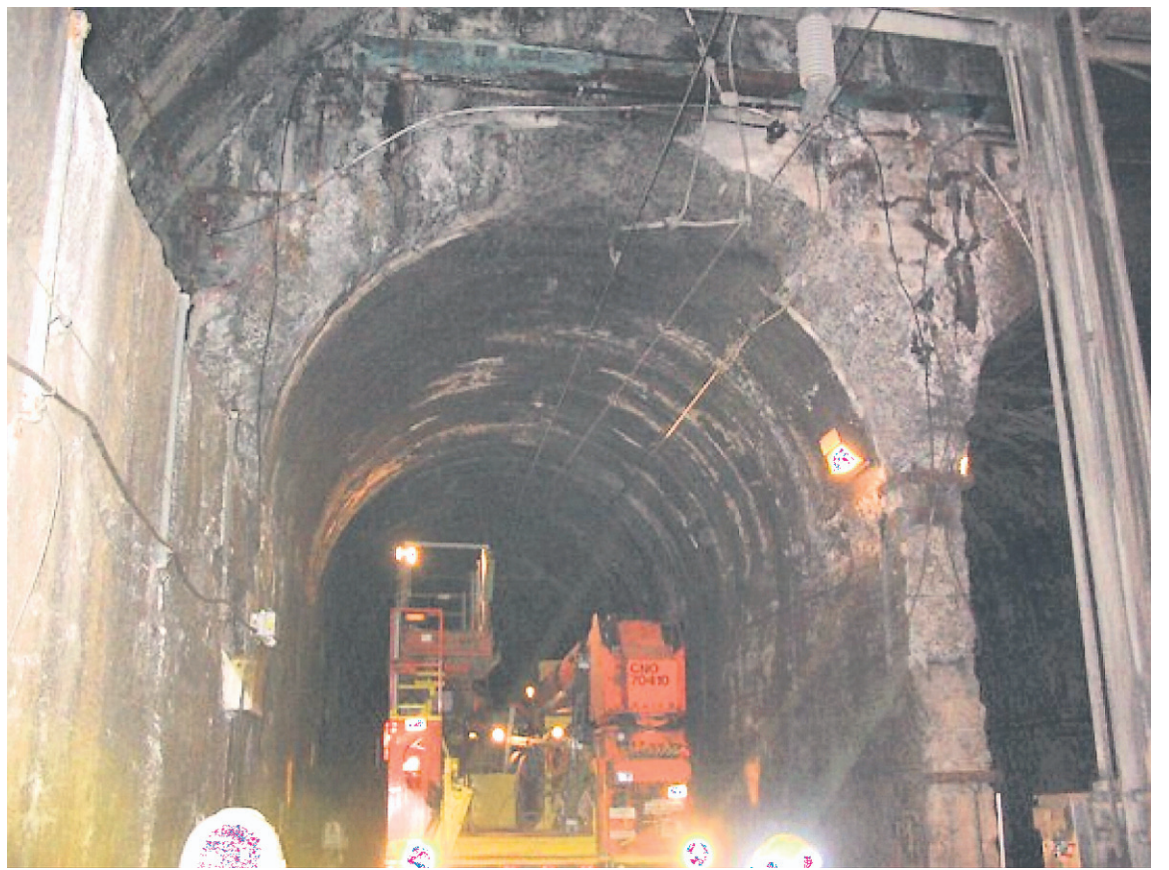
Le portail sud du tunnel du mont Royal.
