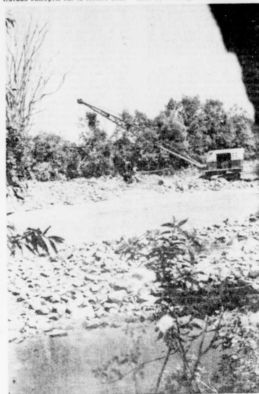
La pelle mécanique d'Excavation Gréco Inc. poursuit son travail de creusage du lit de la rivière.
