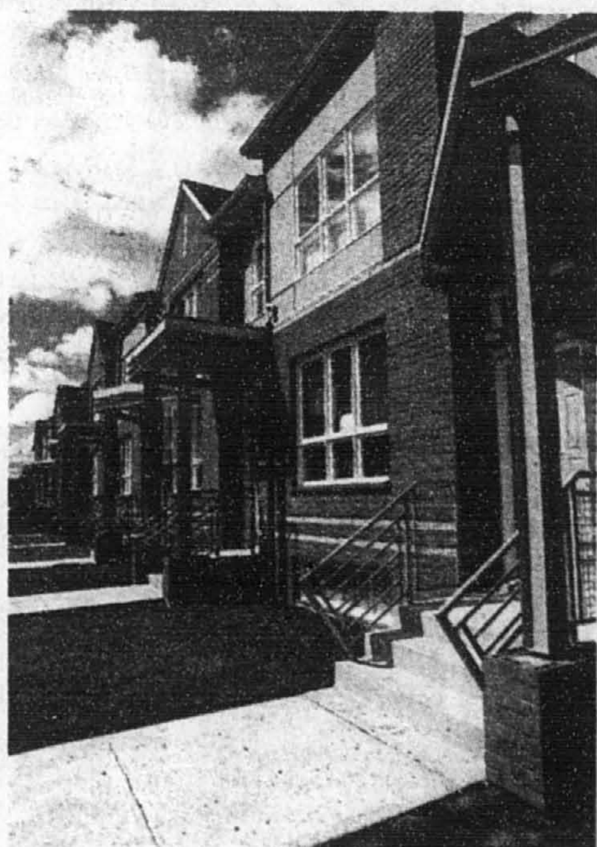
Les auvents supportés par des poutrelles, rue William-Tremblay.
