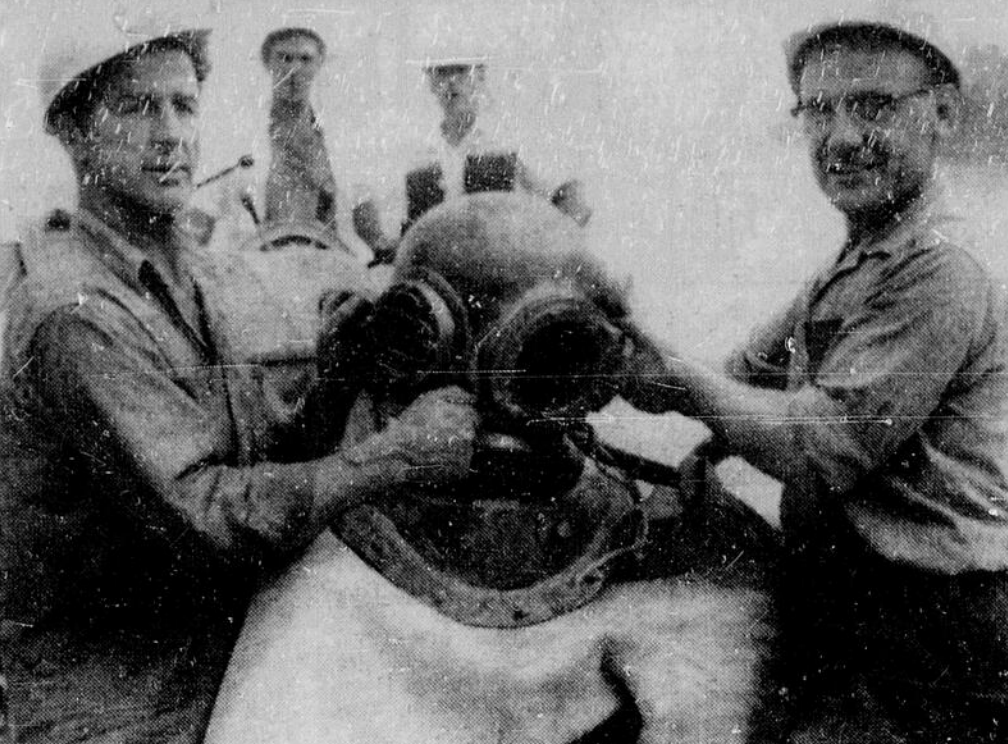
UN SCAPHANDRIER EST TOUJOURS EN DEVOIR — Au cours des travaux de construction des piliers d'un pont, il faut parfois aller sous l'eau faire des vérifications. C'est l'ouvrage du scaphandrier. A gauche dans la photo, M. Roland Moussin, le guide, aide le scaphandrier, M. Philippe Fournier, à la vérification de son équipement.
