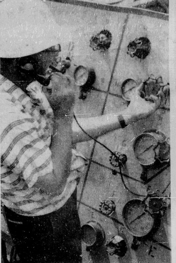
UN PANNEAU DE CONTROLE IMPORTANT — C'est au moyen de ce panneau de contrôle que les compartiments du chaland seront remplis soit d'eau ou d'air comprimé au besoin permettant ainsi au caisson de s'enfoncer sous l'eau dans une position parfaitement horizontale. M. Paul Roy, contremaître de la tuyauterie et de l'installation des compresseurs, vérifie les valves.
