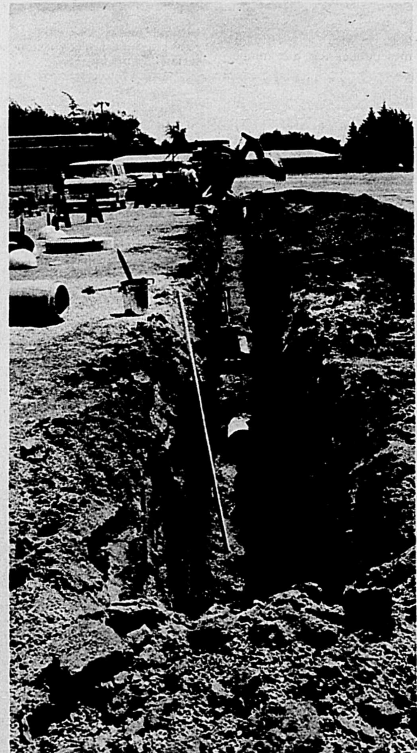
Le futur terrain de baseball qui sera aménagé en face du stade municipal nécessite des travaux de drainage, et par conséquent le creusage de tranchées. De plus, il sera doté d'un système d'éclairage spécial, et pour ce faire, le contrat a été accordé à l'entreprise locale P.P. Electrique la veille de la prise de cette photo, soit lundi, la semaine dernière.
