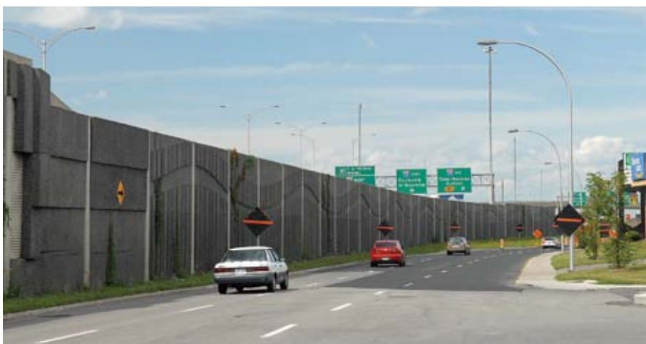
Figure 4.18 La qualité de l'environnement sensoriel de l'arrondissement d'Anjou est régulièrement soulevée en raison des nuisances sonores que génère la traversée de l'autoroute 25.
