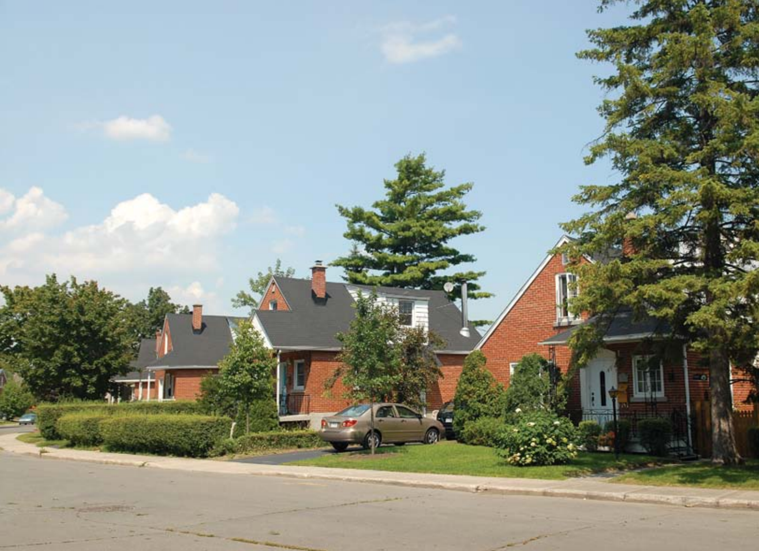
Figure 4.26 Un secteur de l'arrondissement de Verdun marqué par la présence de nombreux bungalows d'après-guerre fait l'objet de demandes de citoyens en vue de préserver de manière plus formelle ses valeurs patrimoniales.
