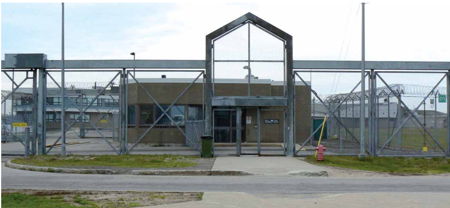
Il y a eu de fortes rumeurs de fermeture d'une aile du Pénitencier de Port-Cartier en 2014. (Photo : archives)
