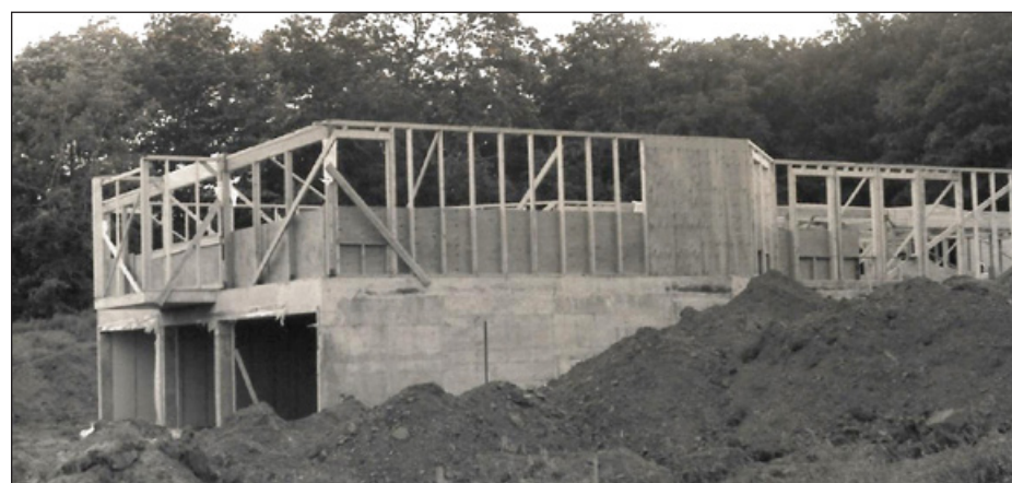
Le début des travaux en 1983.
