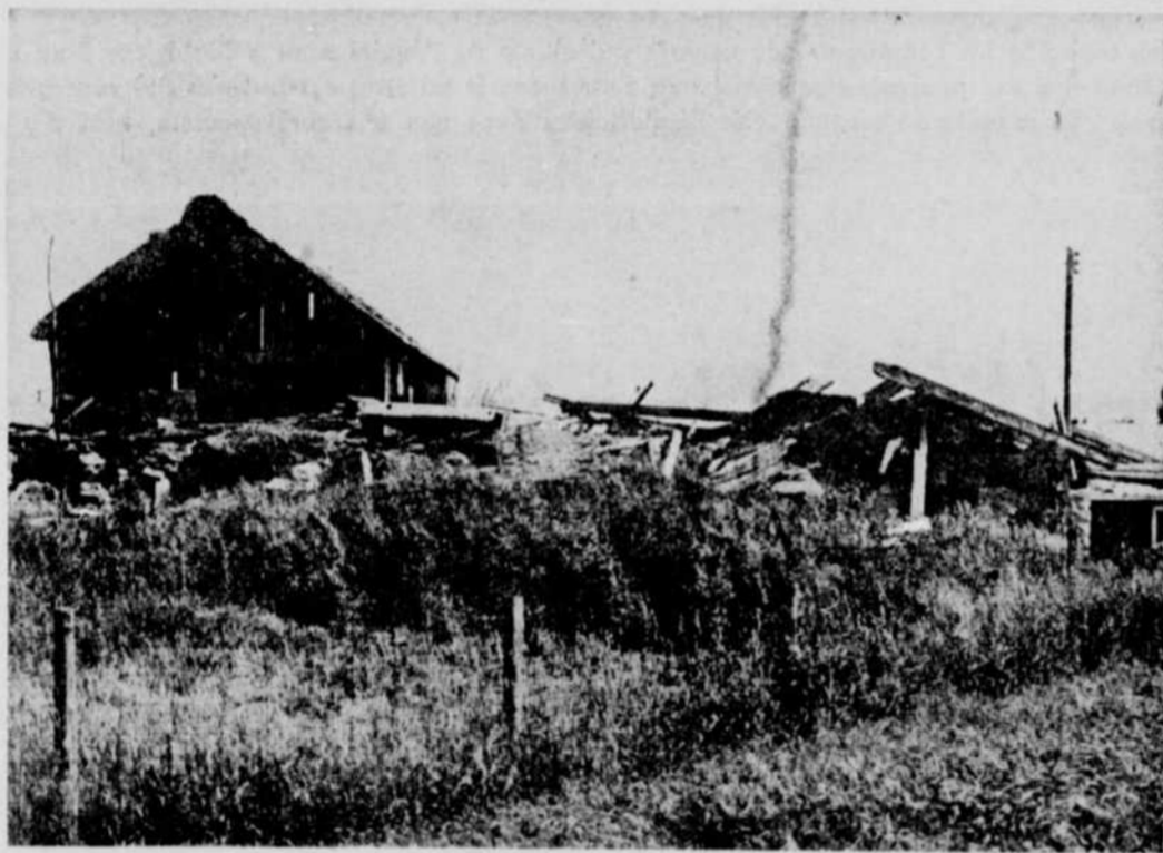
Chaque année des bâtiments de ferme subissent des dégâts semblables à ceux-ci. Le Service de recherches techniques d'Agriculture Canada dispose de plans de construction qui peuvent aider les cultivateurs à protéger plus adéquatement leurs bâtiments contre les méfaits de la mauvaise température. (Article à l'intérieur).
